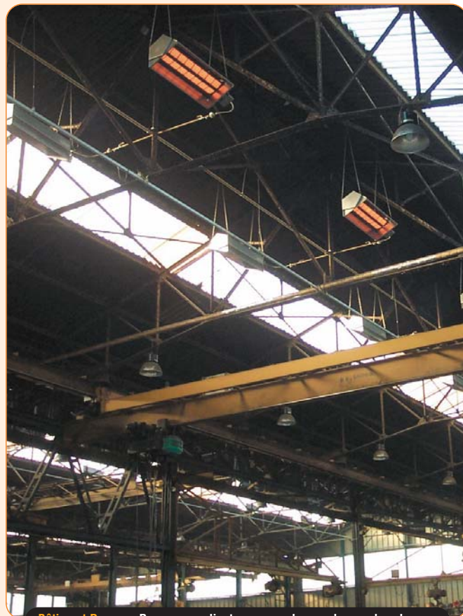
Bâtiment Daussy : Panneaux radiants gaz pour locaux de grands volumes.
